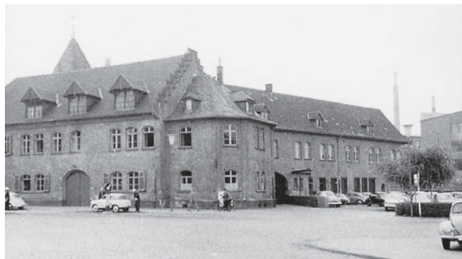
4 In der Anfangszeit der Werkfeuerwehr Hoechst genügte ein Schuppen zur Aufbewahrung des Gerätes. Als 1912 die hauptberufliche Feuerwehr gegründet wurde, entstand in dem schon bestehenden Gebäude A 15 eine Feuerwache. 1918 richtete die Werkfeuerwehr im Gebäude A 18 eine Wache ein, 1960 folgte eine neue Hauptwache in C 299, die immer noch im Dienst ist.
