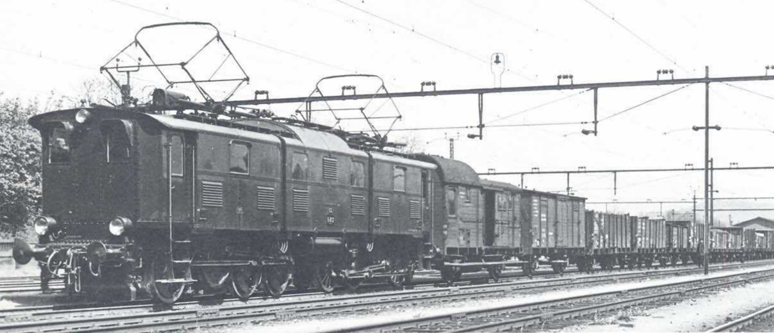
Bild 4: Die Lokomotive mit der Betriebsnummer EG 582 vor einem Güterzug im Bahnhof Hirschberg in Schlesien. Die 14 für den Einsatz in Schlesien gebauten Maschinen besaßen keine Stirnwandtüren, keine Übergangseinrichtungen und nur zwei Stirnfenster. Foto: Sammlung Dr. Scheingraber
