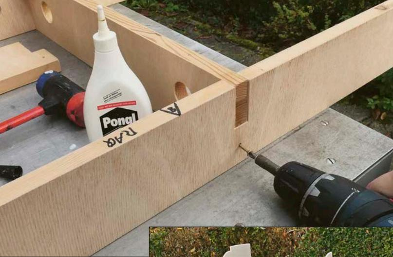
Eine tragfähige Unterkonstruktion darf bei einer anspruchsvollen Modellbahn nicht fehlen. Anstelle von einfachen Holzbrettern haben sich in der Praxis Rahmenkonstruktionen bewährt.
