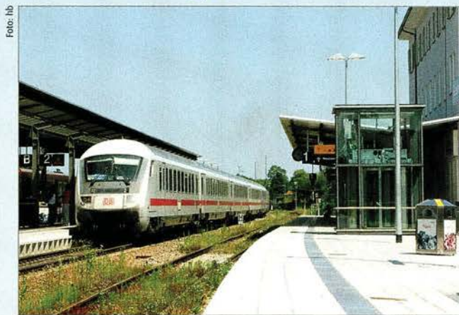
Der Bahnhof Ravensburg an der Südbahn wurde in den letzten Jahren modernisiert – auf Kosten der Stadt. Nicht nur hier wünscht man sich mehr als das eine IC-Zugpaar Dortmund – Innsbruck (Bild).
