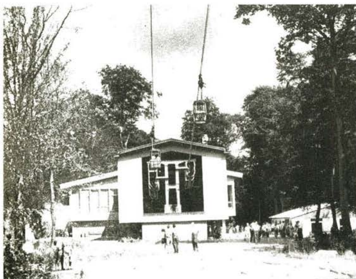
Bild 3 Ausfahrt aus der Bahnsteighalle der Talstation
