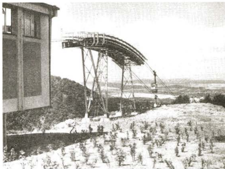
Bild 7 Der Überläufer 2 steht unmittelbar vor der Bergstation
