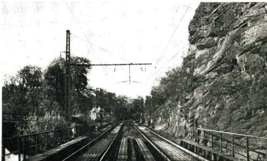
Bild 2 Die Felswand rechts der Strecke machte es erforderlich, die Fahrleitungen beider Gleise am linken Mast zu befestigen
