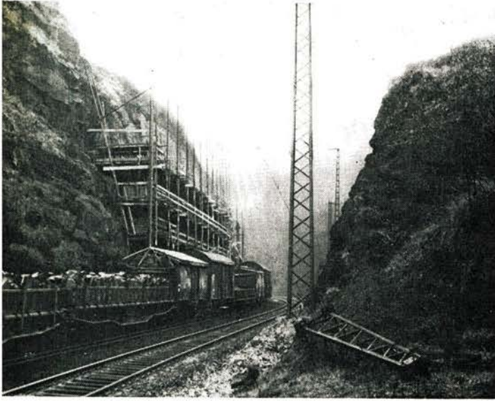
Bild 6 Hangsicherungsarbeiten in einem Einschnitt oberhalb des Tunnels bei Edle Krone. Hier hatten während der Tunnelarbeiten Erd- und Gesteinsmassen beide Streckengleise verschüttet
