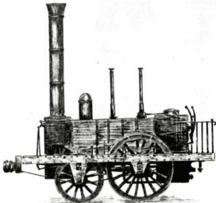
Bild 11 Stephenson's "Planet" von 1830, dem Mercury-Typ angehörende 1 A-Lokomotive. Diese war Vorbild für die erste, von Stephenson für Österreich gebaute Lokomotive "Austria". Für 1837 war diese Type schon etwas veraltet, vorallem war wegen der schlechten Gewichtsverlagerung die Laufeigenschaften nicht überragend.
