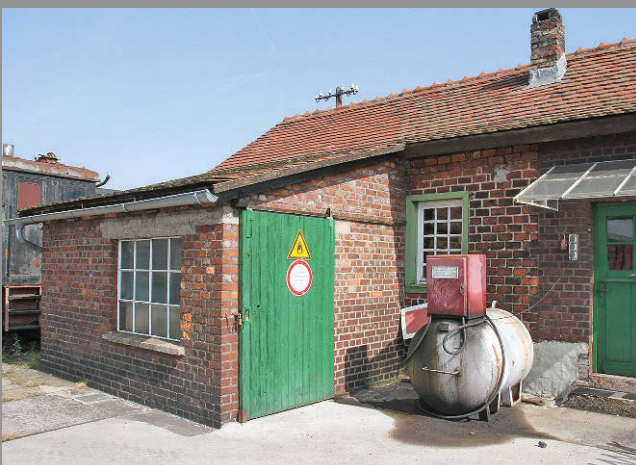
Kleine Gebäude in gemauelter Ziegeloptik und mit einem gewissen alten Charme haben unterschiedliche Aufgaben, vielleicht als Werkstätten oder Heiz- bzw. Kraftstoffraum. Immer wieder schön: Kleinode wie der malerische Hemmschuhständer!
