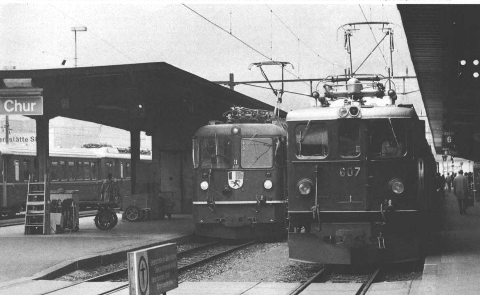
Bild 2: Ausgangspunkt und Zentralbahnhof der Rhätischen Bahn ist Chur, zugleich der Endpunkt der nach Graubünden führenden SBB-Strecke. Die Bahnhofsanlagen sind dementsprechend für beide Spurweiten angelegt. Dieses Bild zeigt die Ge 4/4 b Nr. 607 mit dem Regionalzug 173 Chur—Thusis und die Ge 4/4 d Nr. 617 mit dem Regionalzug 775 am 15.7.1980.
