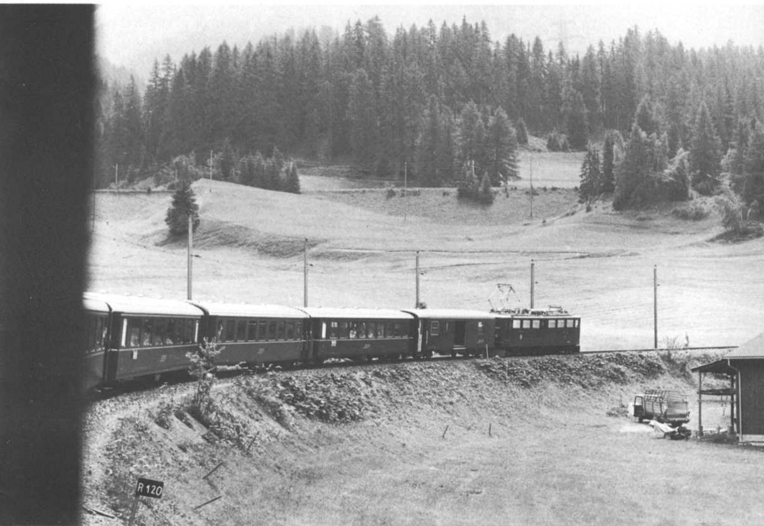
Bild 6: Der »Bernina-Expreß« auf der Fahrt nach Preda kurz hinter Bergün. Im Hintergrund ist die Fortführung der Strecke nach Passieren eines Kehrtunnels zu erkennen. Die Kurve hat einen Radius von 120 m, so daß man aus dem letzten Wagen sehr gut fast den kompletten Zug fotografieren konnte.
