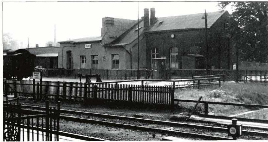
Bild 4: In den vierziger Jahren fungierte dieser Gebäuderest provisorisch als Empfangsgebäude. Es handelte sich um den im oberen Bild nicht mehr sichtbaren rechten, kleineren Flügel. Foto: Sammlung Fromm
