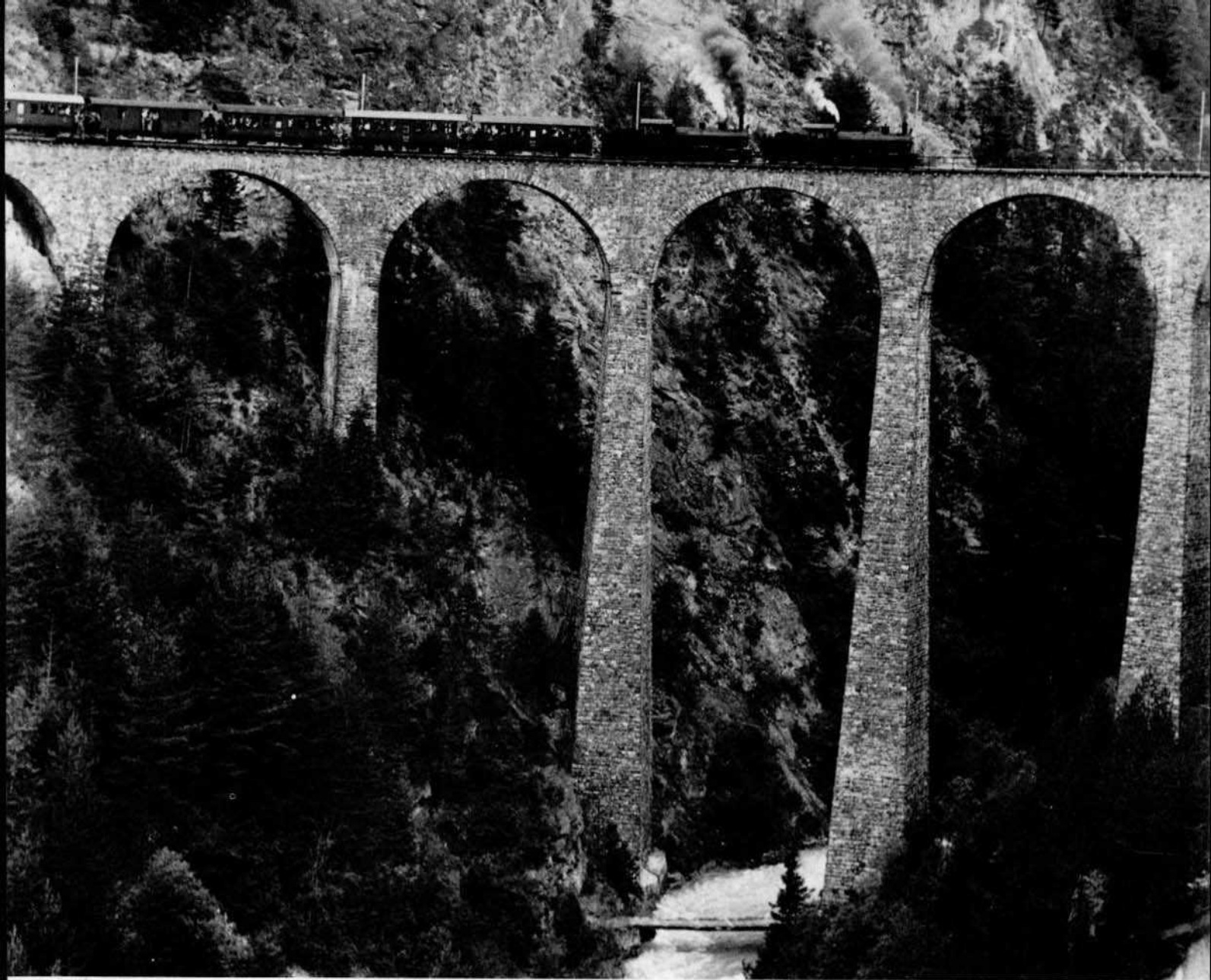
Bild 3: Der imposante Landwasser-Viadukt. Rechts führt die Strecke durch einen Tunnel in eine senkrechte Felswand.
