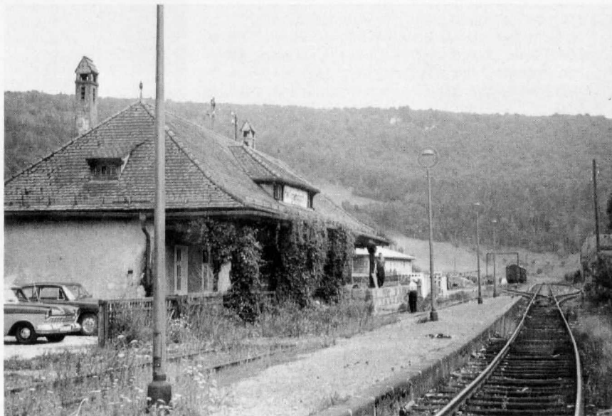
Abb. 18. Nochmals das Stationsgebäude von Heiligenstadt; das Foto von Lutz Reincke gibt auch Aufschluß über Ausführung und Beleuchtung des Bahnsteigs. Schon lange liegen hier keine Gleise mehr – weswegen die Datumsangabe zu Abb. 2 im 1. Teil natürlich auch „26. 6. 1960“ lauten muß; die falsche Jahreszahl schlich sich bei der Korrektur eines anderen Setzfehlers ein und konnte von uns nicht mehr bemerkt bzw. korrigiert werden.
