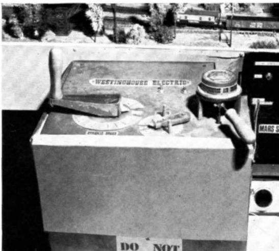
Abb. 1. Der „Original-Fahrschalter“ des Herrn Merz wirkt auf den ersten Blick tatsächlich so echt, als sei er aus einer älteren Eilok oder Diesellok ausgebaut. Links sitzt der Fahrschalter, in der Mitte der Wende- und rechts der Bremsschalter.
