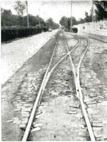
Bild 1 Gelenkzungenweiche an der Ausweichstelle Sanatorium Heilstätte (Linie 1) südlich der Haltestelle Sanatorium Taurus, Gleise im besonderen Bahnkörper in Seitenlage zur Straße
