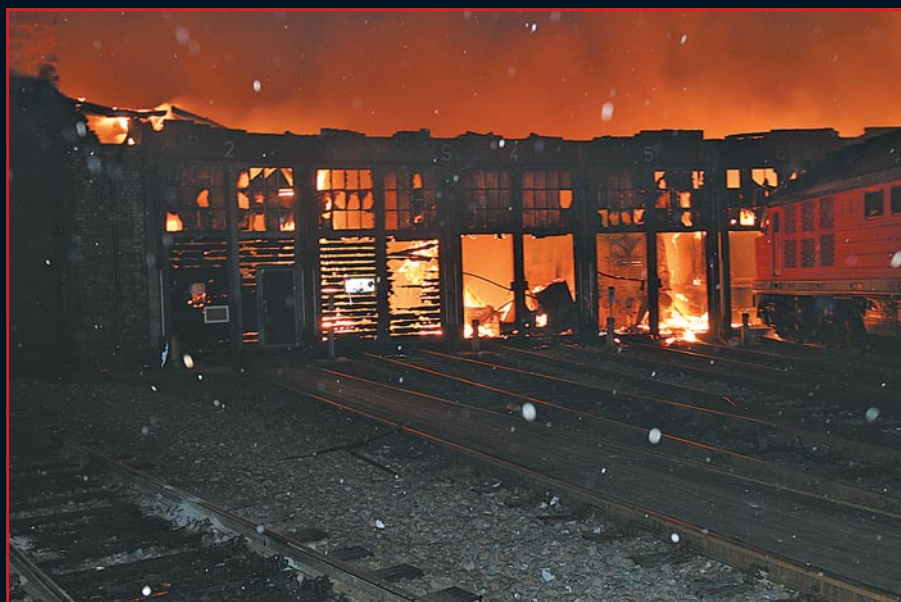
Glühende Holzstücke der Dachkonstruktion regnen auf das Gelände hernieder.
