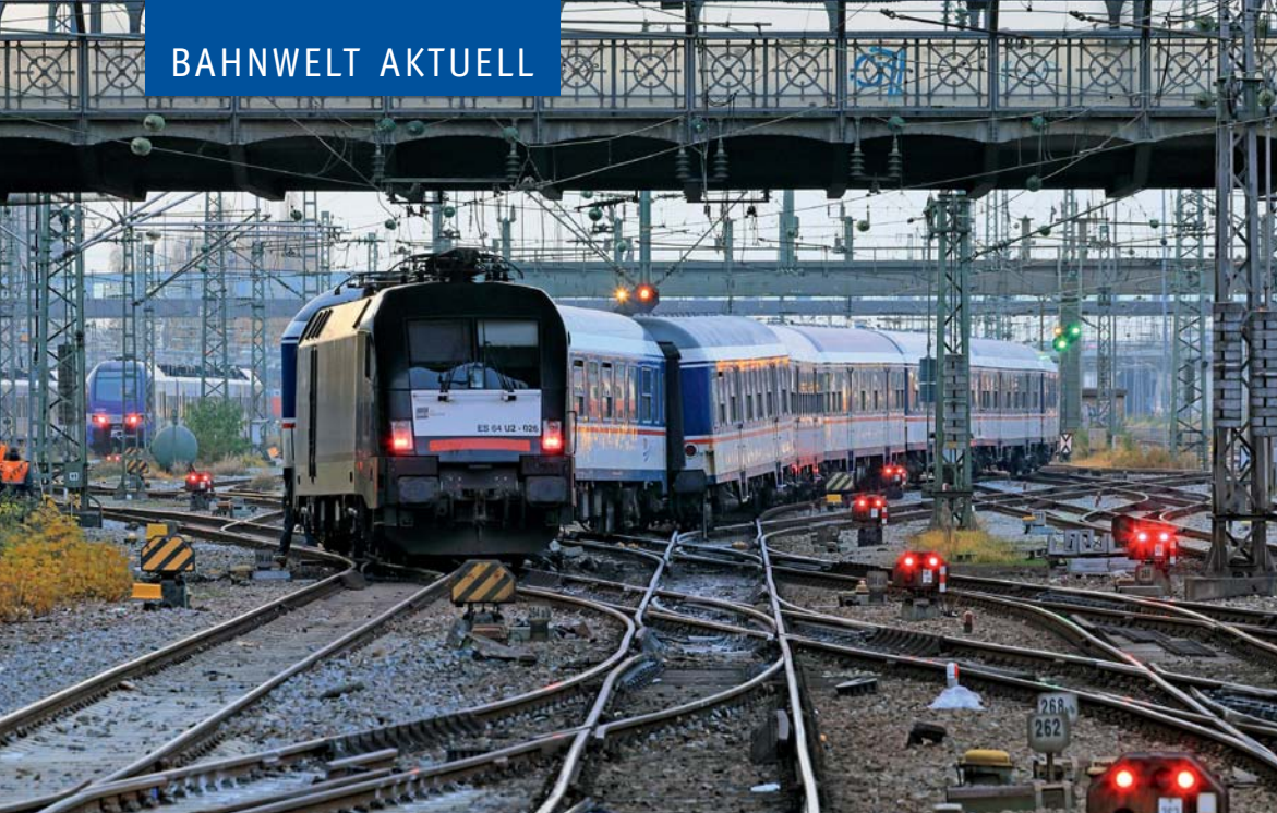
Blick vom Münchner Hauptbahnhof zur Hackerbrücke in Richtung Vorstellgruppe Süd mit der MRCE-Lok 182 526: Bei dem Unglück am 22. November 2019 entgleisten die beiden letzten Waggons (50 80 84-33 282-6 Bduu und 50 80 22-35 819-8 Bnrz) des aus sieben TRI-Wagen gebildeten Meridian-Ersatzzugs.
