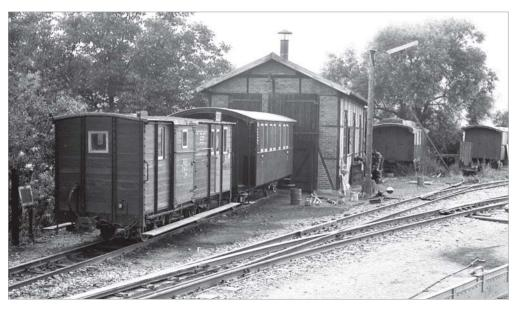
In Möckmühl, dem Ausgangspunkt der schmalspurigen Jagsttalbahn nach Dörzbach, dokumentierte Wolfgang Herdam diesen eingleisigen Fachwerklokschuppen. Für den Rauchabzug genügte offenbar bereits ein schlichter Blechschlot mit Funkenflugschutz.
