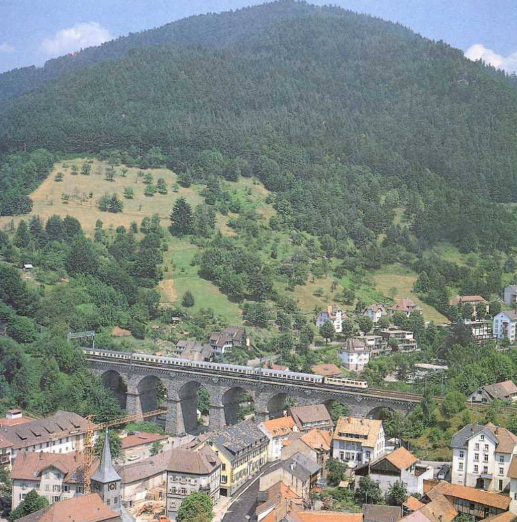
Bilder 1, 2 und 3: Auf kürzester Distanz müssen die Züge der Schwarzwaldbahn von Hornberg (Bild oben) bis Sommerau einen Höhenunterschied von knapp 450 m überwinden. Robert Gerwig (Bild links das Gerwig-Denkmal beim Bahnhof Triberg) löste das Problem mittels Doppelschleifen bei Niederwasser und Triberg. Das Foto rechts (bei Triberg) läßt die aufwendige Trassierung erahnen. Bei genauem Hinsehen sind drei Tunnelportale zu erkennen.
