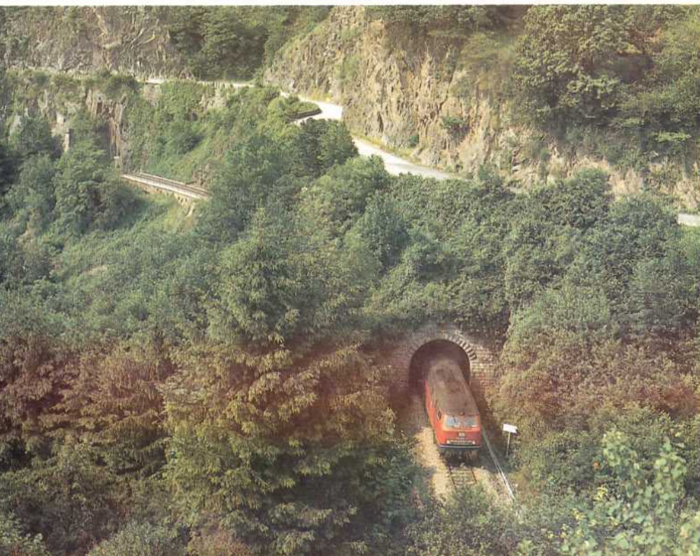
◀ Bild 5: Tunnel an Tunnel reiht sich im Verlauf der Murgtalbahn bei Forbach-Gausbach. Die 218 274 verläßt soeben den Rappentunnel. Foto: G. Wagner
