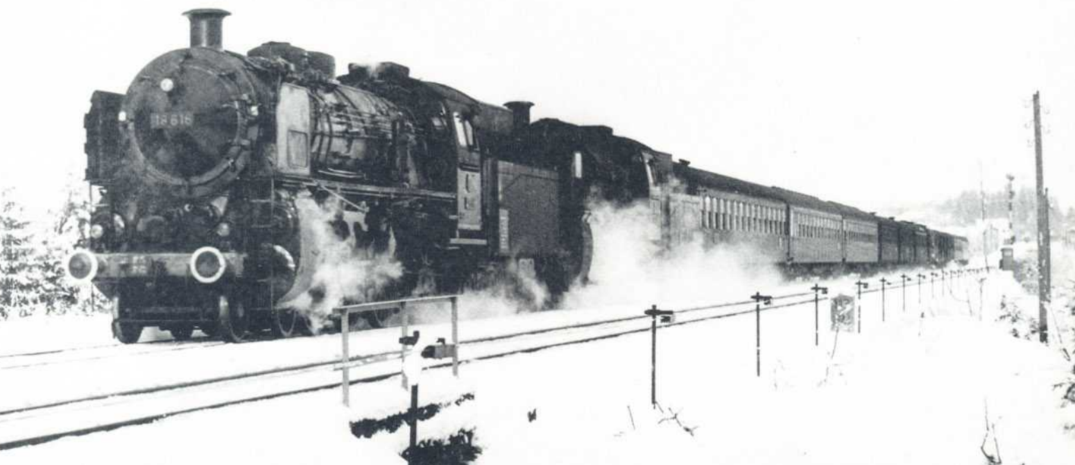
Bild 10: Oftmals waren zwei Schnellzuglokomotiven der bayerischen Gattung S 3/6 mit einer Leistung von zusammengerechnet fast 4000 PS erforderlich, um die schweren Schweizer Schnellzüge über die langen Rampenabschnitte der Allgäubahn zu befördern. Vorspannlok war im Dezember 1960 bei Rothenbach die 18 616.
