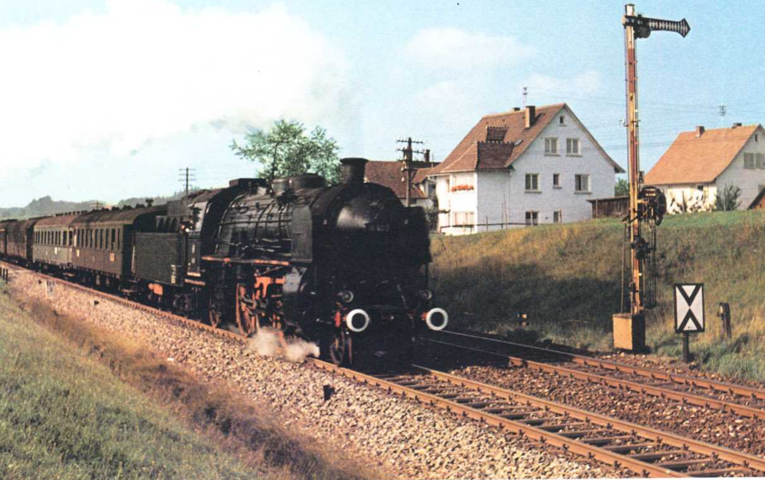
Bild 1: Im September 1962 konnten die mit Ersatzkessel ausgerüsteten S 3/6 des Bw Lindau vor den schweren Schweizer Schnellzügen auf der Allgäubahn noch zeigen, was in ihnen steckt. Die 18 603 eilt bei Hergensweiler mit dem ersten Schnellzug von Genf in Richtung München. Beachtenswert ist auch die bayerische Signalkombination am rechten Bildrand. Foto: G. Turnwald
