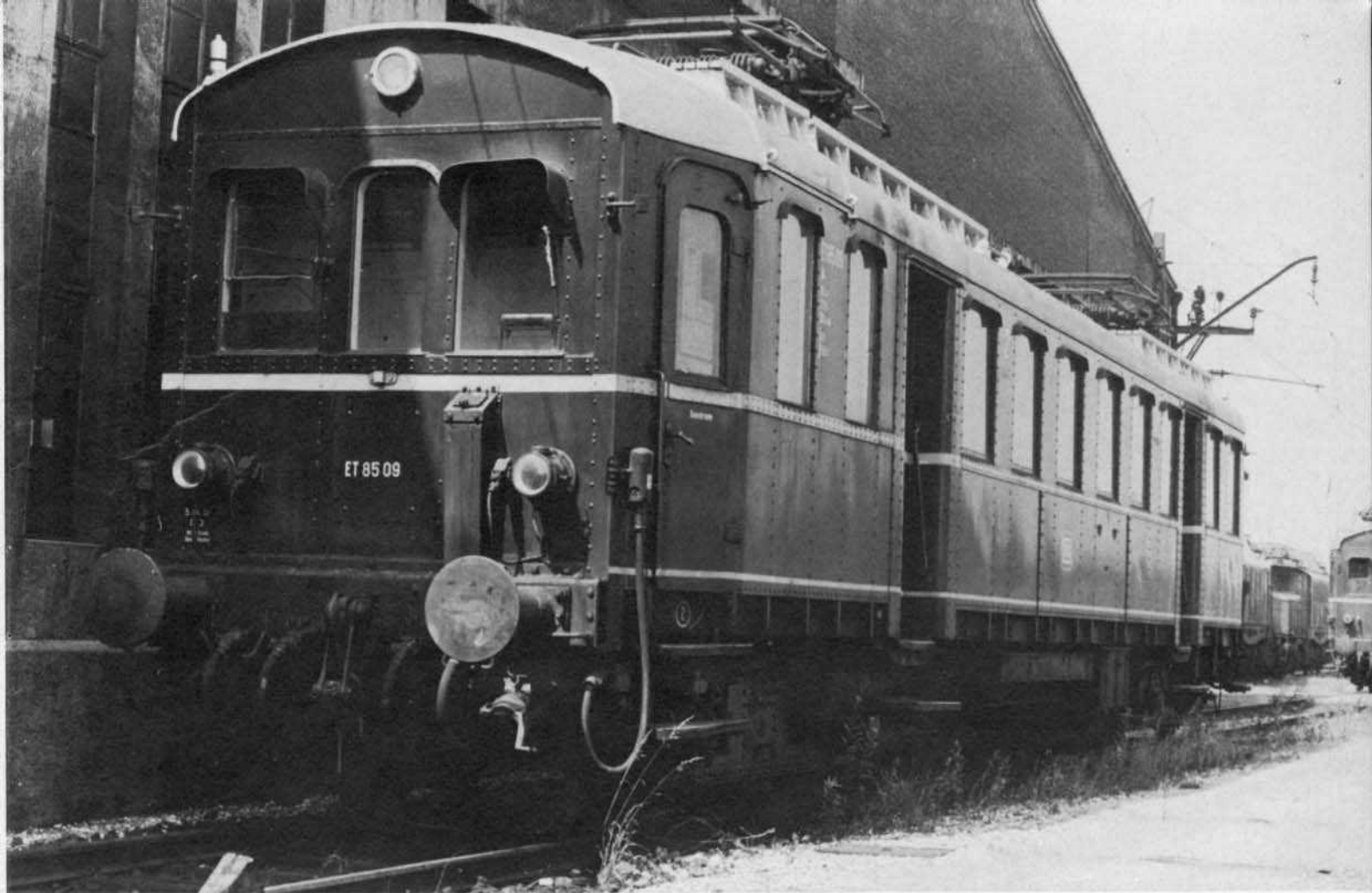
Bild 1: Bis zur Betriebsnummer ET 85 09 und ES 85 04 hatten die Fahrzeuge hinten angeschlagene Türen zu den Führerräumen. Foto: HJO
