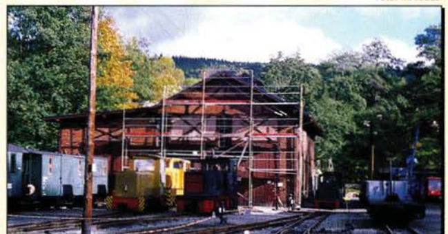
Heute ist der Lokschuppen Kernstück eines Eisenbahnmuseums. Am 13. Oktober 1998 wurde die Fassade gerade saniert.
