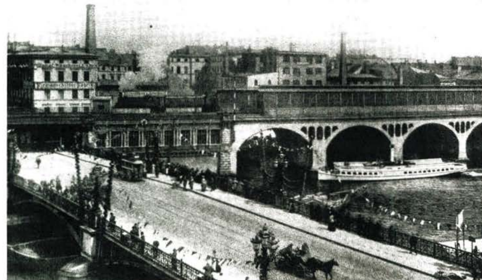
Bild 3 Am Bahnhof Jannowitzbrücke ist deutlich zu erkennen, wie die Stadtbahnbogen im Flußbett der Spree stehen (etwa um 1895). Der ausfahrende Zug rollt in Richtung Alexanderplatz.
