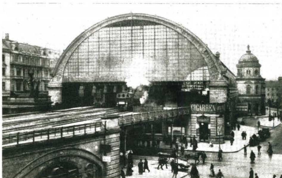
Bild 1 Blick auf die östliche Ausfahrt des Bahnhofes Alexanderplatz mit ausfahrendem Stadtbahnzug in Richtung Jannowitzbrücke. Im Bild rechts der ehemalige Bahnhofsvorplatz in der Dirksenstraße. Links: Die ehemaligen Königskolonaden, die ursprünglich zum architektonischen Schmuckwerk der Brücke über den Königsgraben gehörten (etwa um 1895).
