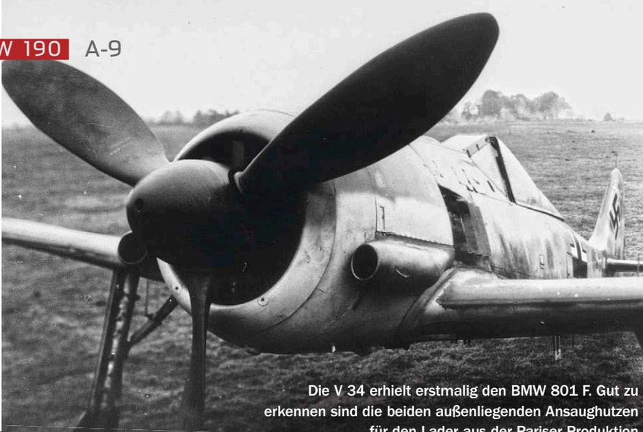
Die V 34 erhielt erstmalig den BMW 801 F. Gut zu erkennen sind die beiden außenliegenden Ansaugutzen für den Lader aus der Pariser Produktion
