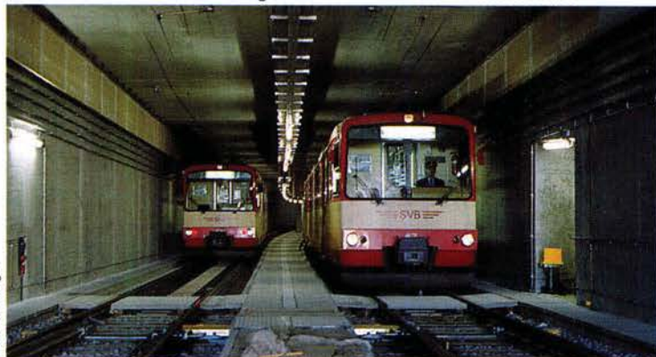
Zwei Garnituren der Salzburger Lokalbahn in der Tunnelstrecke
