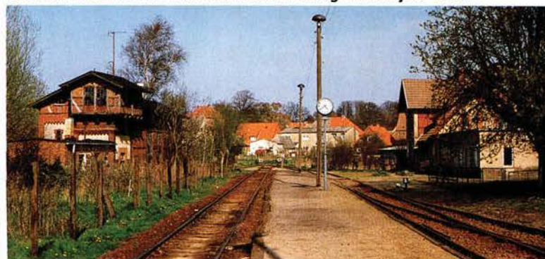
Bahnhof Klütz kurz vor der Betriebseinstellung im Frühjahr 1995.
