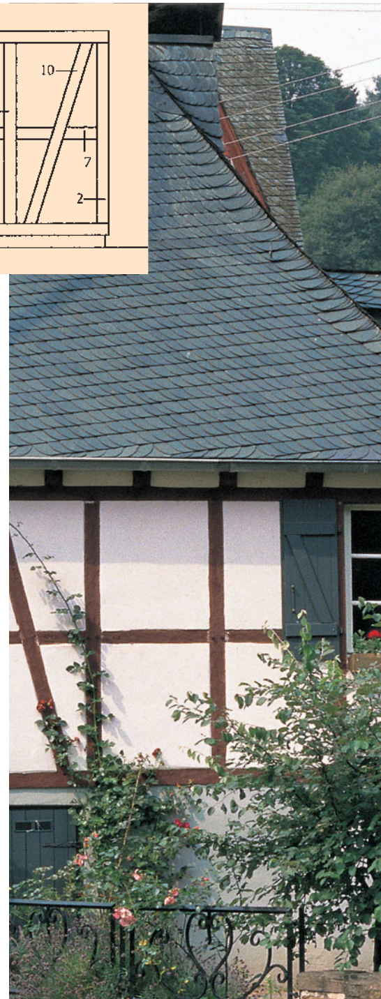
Einfache Bauweise mit wildromantischem Charme im Eifeldorf Monreal. Wesentlich schlichter ist die Fachwerkkonstruktion hier ausgefallen. Man beachte die z.T. stark verzogenen Fachwerkbalken und die eine oder andere Fassade, die sich im Laufe der Zeit zu neigen begonnen hat.
