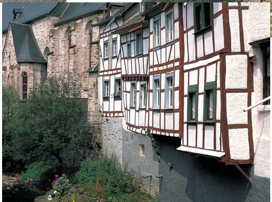
Einfache Bauweise mit wildromantischem Charme im Eifeldorf Monreal. Wesentlich schlichter ist die Fachwerkkonstruktion hier ausgefallen. Man beachte die z.T. stark verzogenen Fachwerkbalken und die eine oder andere Fassade, die sich im Laufe der Zeit zu neigen begonnen hat.
