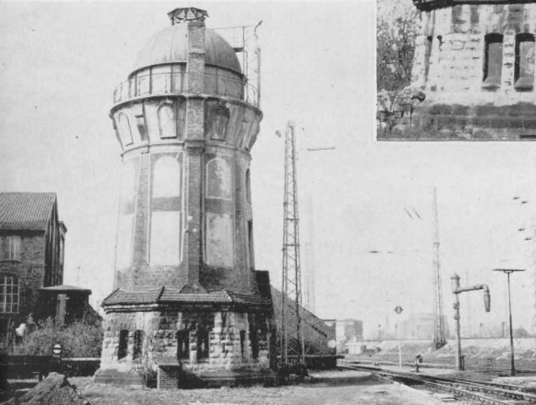
Abb. 1 u. 2. Der heutige Zustand des Wasserturms von Bielefeld, der auf der oberen Abbildung in ca. \frac{2}{3} HÖ-Größe wiedergegeben ist. Bis auf die zugemauerten Fensteröffnungen und kleinere Änderungen an Schornstein und Schutzgeländer ist sein Zustand unverändert.
