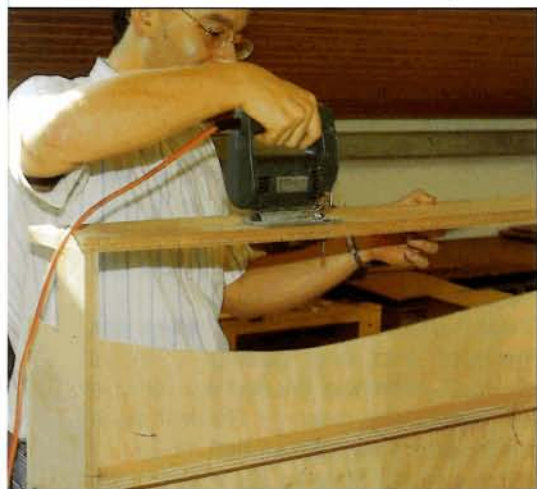
Bild 20: Wegen des tieferliegenden Fluß-bettes der Lahn muß der Rahmen ausge-schnitten werden. Für diese Arbeit sollte man die Segmente wieder auseinanderschrauben.
