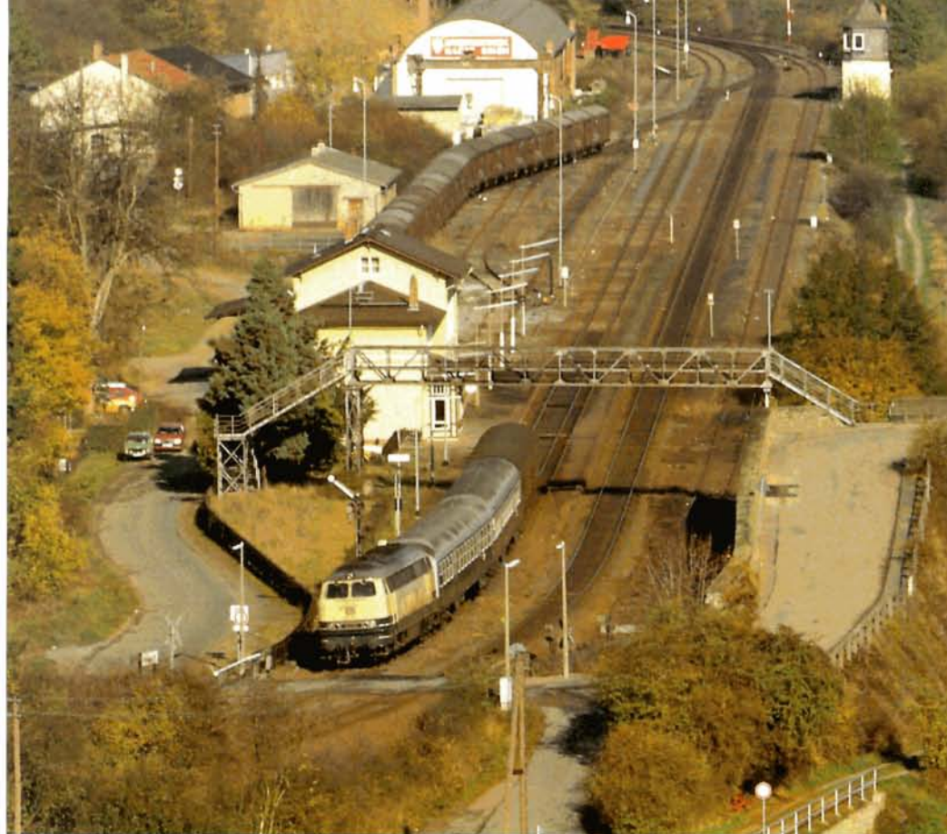
Bild 4: Bahnstansicht von Villmar aus dem Jahre 1988: Ein Teil der Gleisanlagen ist bereits zurückgebaut. Das ehemalige rechte Überholgleis ist nur noch ein Abstellstumpfgleis. Dennoch blieb die ehemalige Abzweigweiche zum Durchfahrungsgleis liegen.
