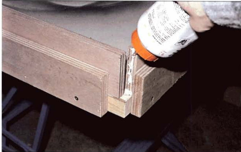
Bild 10: Die Rahmenbretter werden entlang der Anschlagbretter ausgerichtet und mit Weißleim verklebt.
