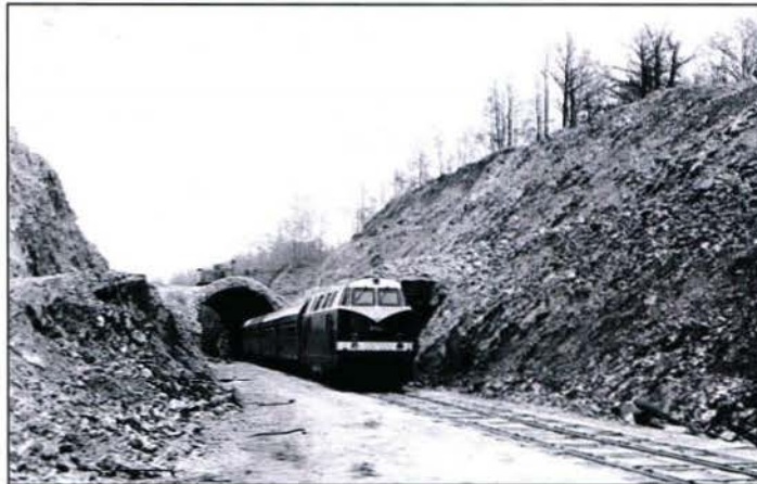
Der Rest des Saalbachttunnels im März 1987.
