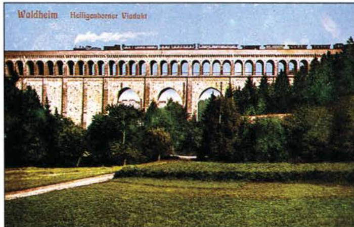
Ansichtskarte von 1915, Blick von Süden. Bemerkenswert die bei Brücken seltene Ausführung der Hauptöffnungen als Spitzbögen, wodurch die Horizontalkräfte der Wölbungen minimiert werden sollten. Sammlung Berger
