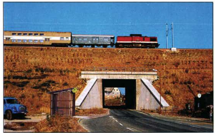
Der bereits verschüttete Viadukt in Crossen.
