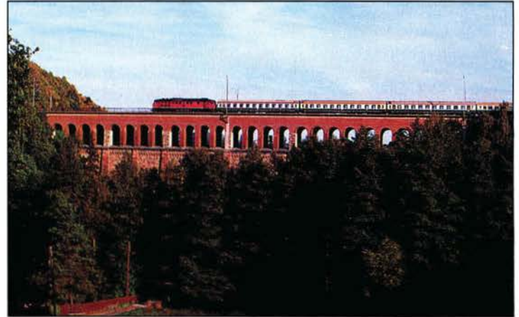
Der mit Fahrleitungen ausgerüstete Viadukt über die Zschopau in Limmritz.
