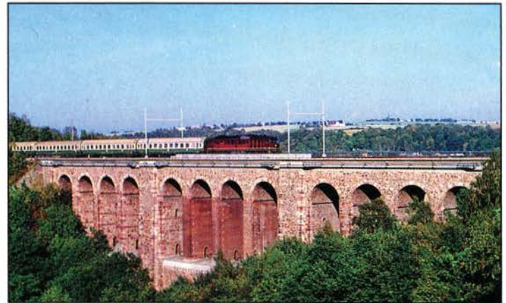
Kummersmühlviadukt an der Bahnhofseinfahrt Waldheim.
