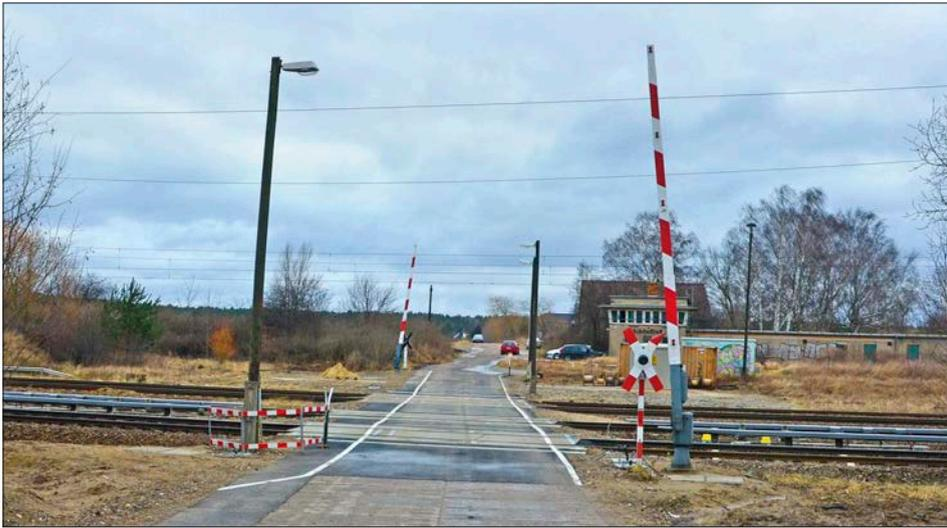
Örtlich bediente, elektrische Vollschranke, ergänzt mit WSSB-Blinklicht. Die Vollschranken weisen Reflektoren auf, da das Warnmuster nicht reflektierend ist. Bild: Bernd Stahr
