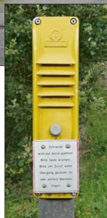
Oben: Anrufschanke in der Halbtotale. Sie wird vom nächsten Stellwerk geöffnet, sofern gerade kein Fahrweg auf der Strecke gestellt ist. Zu sehen auch die Lackierungsvariante von 1961 mit den schrägen Rotflächen an einer Vollschanke.
