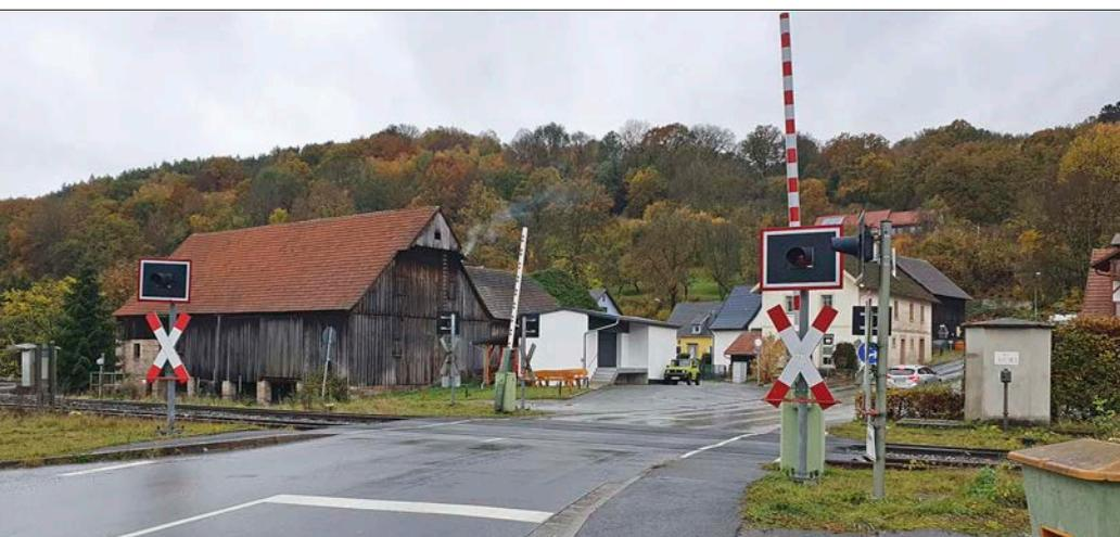
Diese Kombination einer zugbedienten Halbschrankenanlage entspricht dem Ideal von 1961. Charakteristisch waren hier die schräg angeordneten roten Sperrstreifen und am Ende die runde Reflektorscheibe, da Schranken zu jener Zeit nicht mit reflektierender Folie beklebt, sondern nur lackiert waren.
