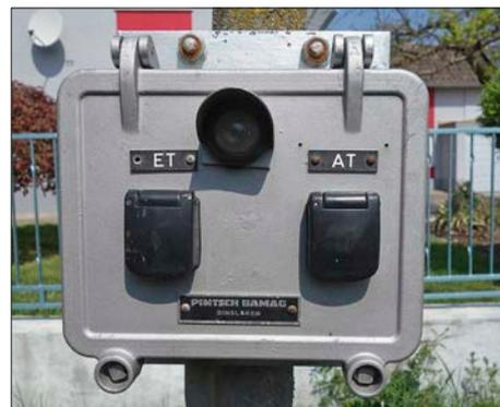
Oben: Schlüsselschalter für manuelles Ein- und Ausschalten bei defekten Schaltkontakten
