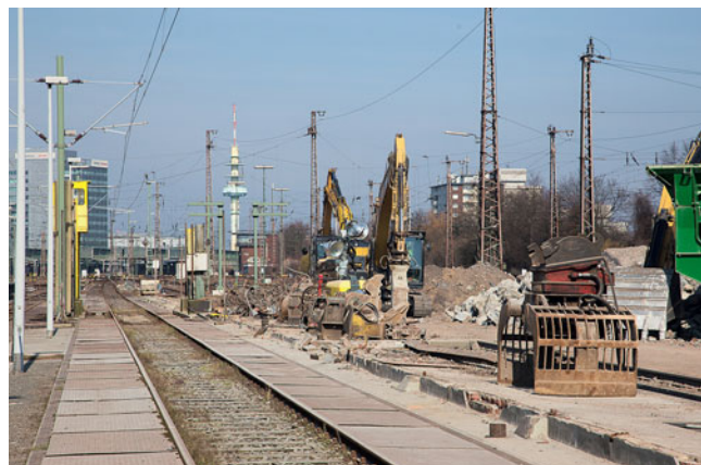
Auf dem Gelände des ehemaligen Bww Duisburg Hbf entsteht bis zum Herbst die neue Abellio-Werkstatt für Flirt III-Züge (14. März 2016).
