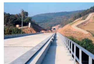
April 1987: „Lückenschluss“ beim Bau der NBS zwischen Fulda und Würzburg.
