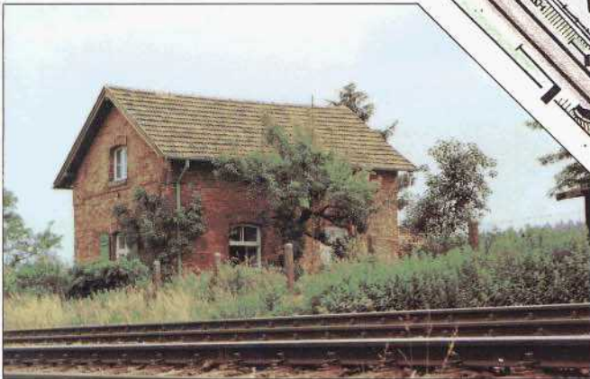
Bild 4: Ein Bahngelände an der aufgelassenen Haltestelle Büchelberg.
