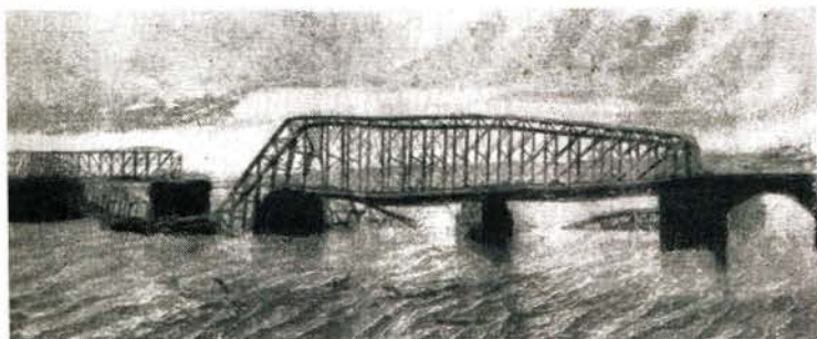
Bild 2 Die eingestürzte Eisenbahnbrücke bei Riesa im Februar 1876. (Nach einer zeitgenössischen Darstellung.)
