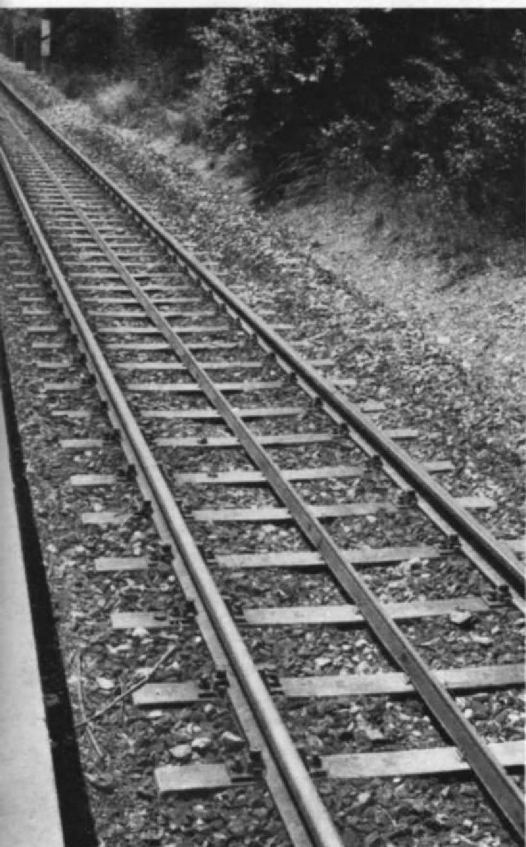
Abb. 1. Die neue „Mittelschiene“ in einem Gleis der Münchner S-Bahn.
