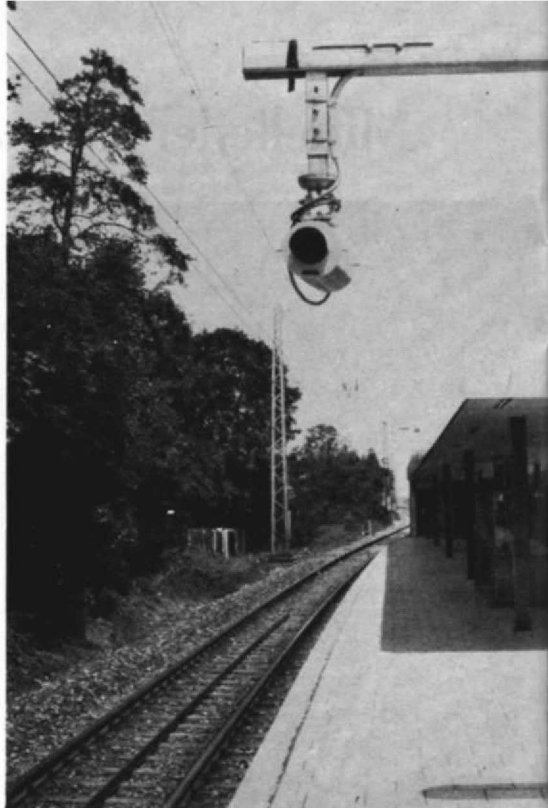
Abb. 5. Eine der Fernsehkameras am Bahnsteig. Bis zu drei dieser Kameras „schauen“ am Zug entlang. Für eine H0-Modellausführung könnte man evtl. die Kibri-Scheinwerfer Nr. 5845 verwenden.
