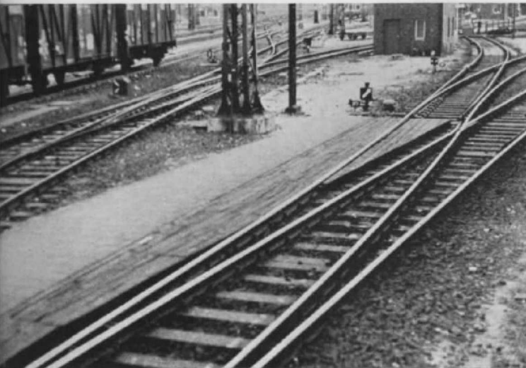
Abb. 1. Etwas primitiv anmutend, aber durchaus zweckentsprechend: der mit Holzbohlen verlängerte Bahnsteig in Münster Hbf. Es sieht fast so aus, als wäre der für diese Notlösung verantwortliche DB-ler ... Modelleisenbahner!
