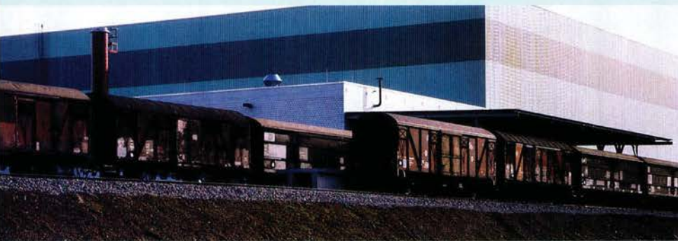
Vor drei Jahren richtete die Firma Sigloch diesen Gleisanschluß ein.
