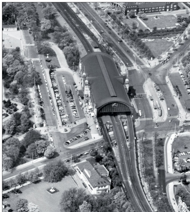
Dammtor in den 70ern. Gut zu erkennen, wie sich Fern- und Nahverkehrsgleise durch die Halle schlängeln. Foto: Archiv Michael Meinhold
