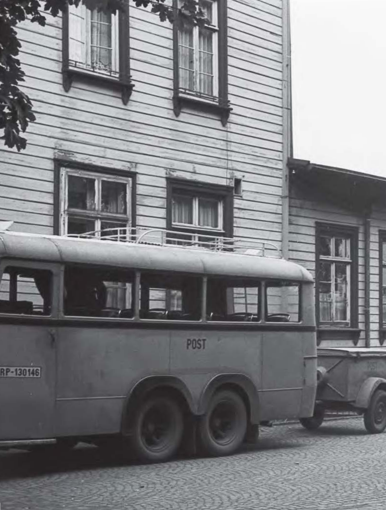
BAHN UND BUS / 2 Unstrittig planmäßig dagegen ist dieses Omnibus-Stelldichein auf der Straßenseite des Bahnhofs Rhaden, das der Beamte der Fahrkartenausgabe scheinbar kritisch in Augenschein nimmt – aufgenommen um 1952. Allein der Anblick des kantigen Heckteils des wuchtigen Dreiachlers samt Anhänger im Verein mit der
