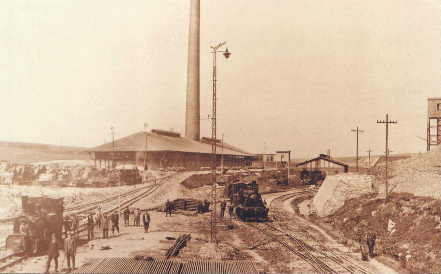
Bild 11: Schon um 1910 verfügten die Rheinischen Kalksteinwerke in Rohdenhaus (bei Wülfrath) über recht umfangreiche Gleisanlagen. Links die Schmalspurgleise, auf denen der Kalkstein von den Brüchen zum Brennofen gefahren wurde, und rechts die Normalspurgleise. Nach dem Brennen verlud man den Kalk in normalspurige Klappdeckelwagen, die von einer Werklok des Kalkwerkes in den Übergabebahnhof Rohdenhaus gefahren wurden. Foto: Stadt- und Heimatmuseum Wülfrath, Sammlung Feldmann
