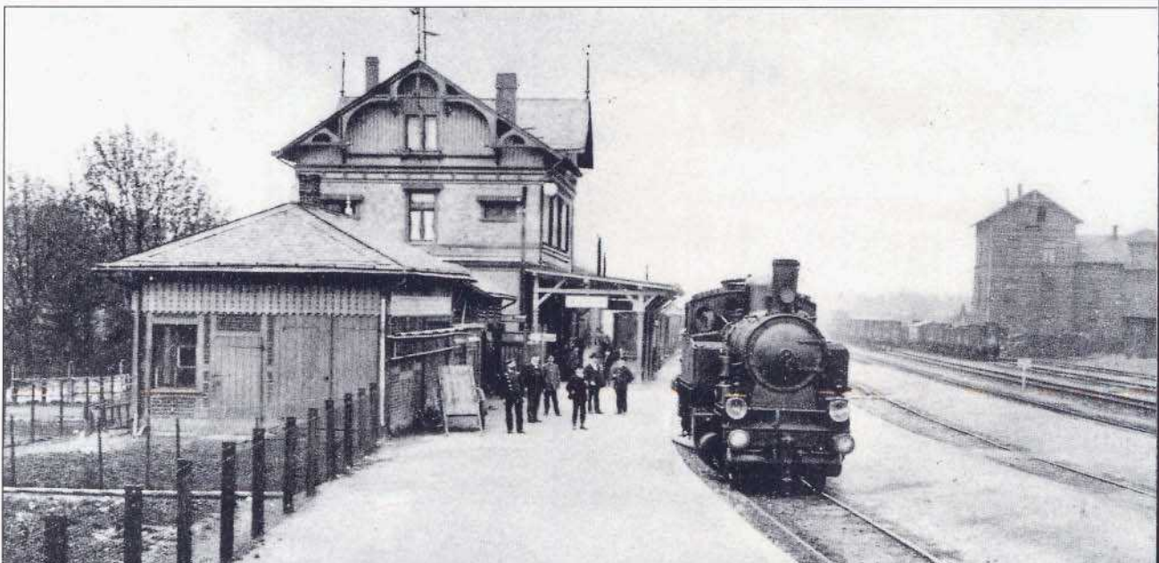
Bild 12: Die preußischen T 3 wurden schon bald von den wesentlich leistungsfähigeren Tenderlokomotiven der Gattung T 9 aus dem Zugdienst auf der Angertalbahn verdrängt. Bahnhof Wülfrath um 1906. Foto: Foto-Becker (Wülfrath), Slg. Feldmann
