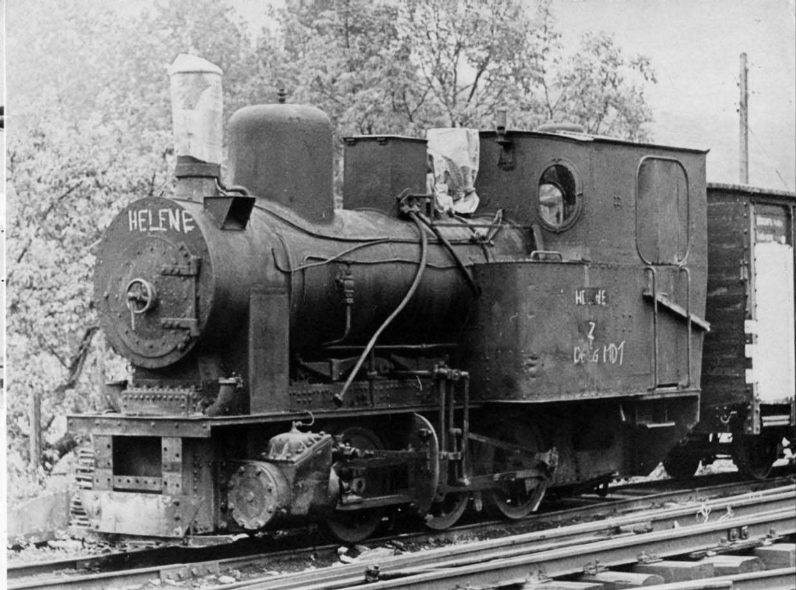
Bild 9: Als die „Helene“ im Jahr 1970 in Möckmühl eingetroffen war, blieb für die freiwilligen Helfer der DGEg noch eine Menge Arbeit, um die Lok für den Museumsbetrieb im Jagsttal herzurichten.
