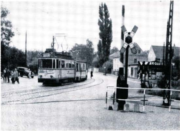
Bild 1 Die Halbschrankenanlage in der Grundstellung
