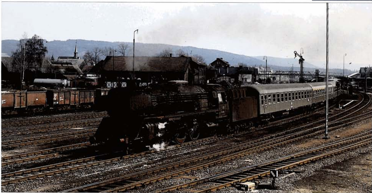
Bild 7: 1846 erreichte der erste Zug von Bamberg kommend den Bahnhof Neuenmarkt-Wirsberg. An der Talstation der Steilrampe nach Marktschorgast wurde hier eine Lokstation errichtet, deren Anlagen auf dieser Aufnahme vom Mai 1973 hinter der 001 088 (mit E 658 nach Bamberg) zu erkennen sind.
