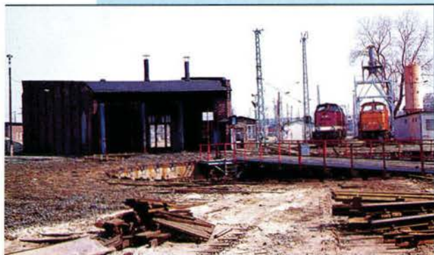
Schuppen 3 des Bh Cottbus im Abrißzustand.
