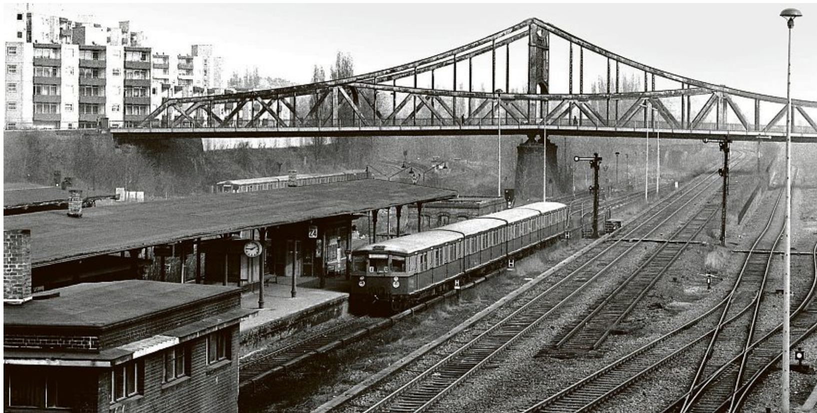
Als der Ring noch geteilt war: Ein S-Bahn-Zug fährt 1979 in die Kehranlage des Bahnhofs Gesundbrunnen. HERMANN KUJOM/SAMMLUNG SVEN HEINEMANN
