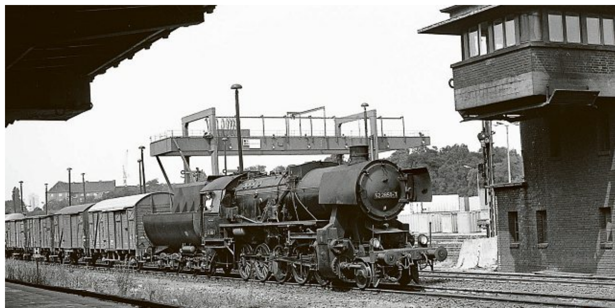
Wichtig für den Frachtverkehr: ein Güterzug am Stellwerk B2 am S-Bahnhof Frankfurter Allee. BURKHARD WOLLNY
