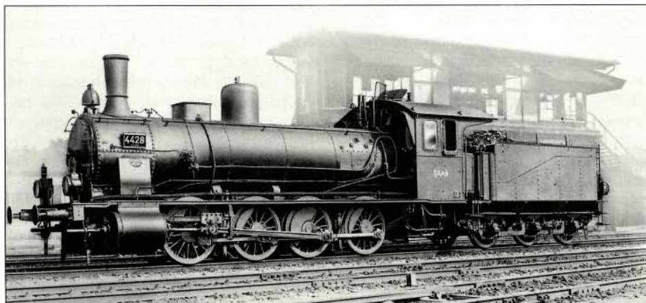
Bild 5 (oben): G 7 2 2096 CASSEL, die Verbundauführung der vierfach gekuppelten Naßdampf-Güterzuglokomotive. Foto: Sammlung Weisbrod
