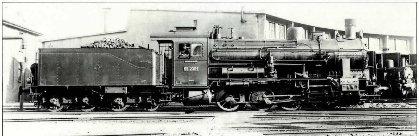
Bild 14: Die 55 2351, eine der G 9-Lokomotiven mit Lentz-Ventilsteuerung. Auf dem rechten Laufblech Knorr-Luftpumpe und Hauptluftbehälter. Foto: Sammlung Weisbrod
