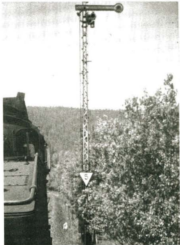
Bild 3 Das bei Einfahrt eines jeden Zuges aus Sicherheitsgründen „Hf0“ zeigende Signal „B“ des unteren Bahnhofs. Es durfte erst auf „Fahrt frei“ gestellt werden, nachdem der Zug vor ihm gehalten hatte und die Einfahrweiche, die ansonsten stets auf ein „Sandgleis“ wies, umgestellt worden war. Die Geschwindigkeitstafel „Lf 4“ ließ dann die Einfahrt mit 50 km/h zu.
