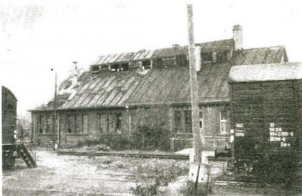
Bild 3 Der alte Lokschuppen im Bf Erfurt West im heutigen Zustand
