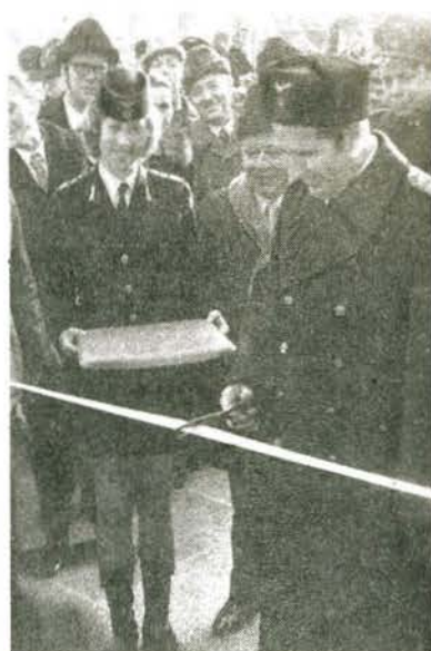
Bild 1 Baubeginn für das neue Empfangsgebäude, Januar 1970
