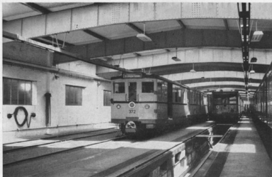
Abb. 11. Nochmals eine deutliche Aufnahme von den Stromschienen an der Decke.
