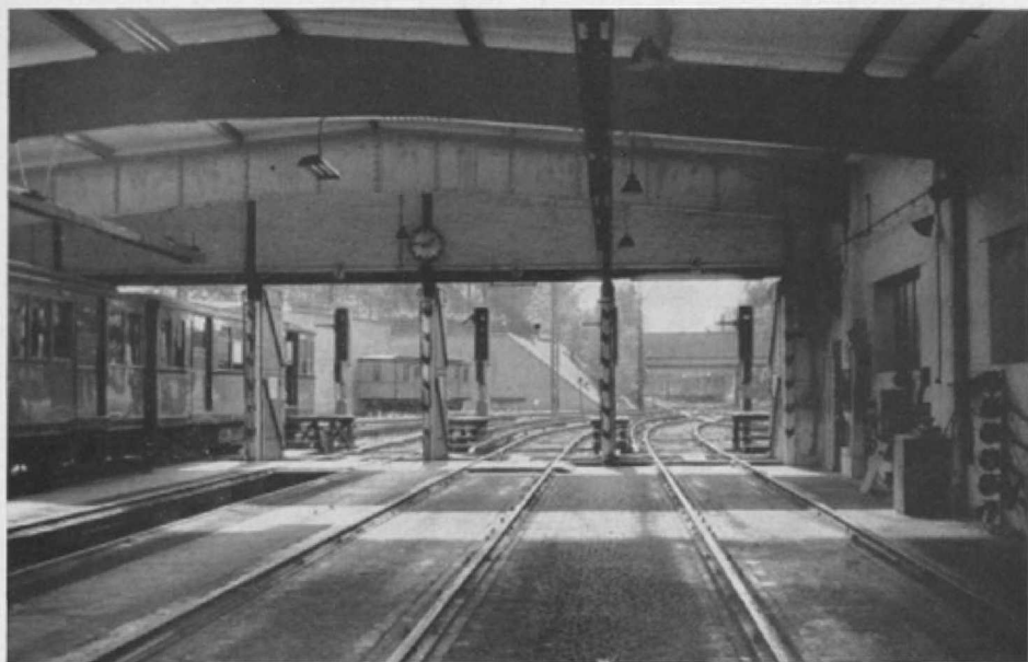
Abb. 10. Der Ausblick aus der Abstell- und Werkstatthalle läßt deutlich erkennen, daß die seitlichen Stromschienen vor der Halle aufhören und zum Teil unter der Decke zu entdecken sind.
