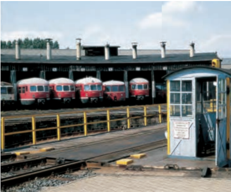
36 Bahnbetriebswerke Sonntags-Visite in Limburg
