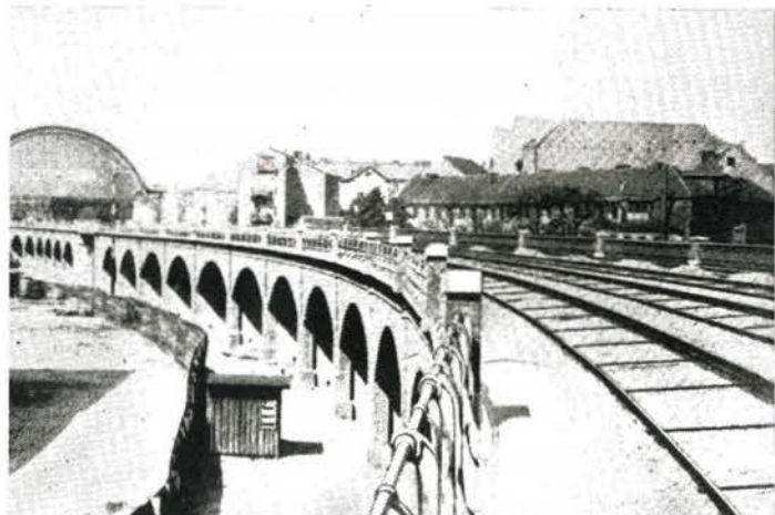
Bild 1 Viaduktstrecke zwischen den Bfn Jannowitzbrücke und Alexanderplatz kurz vor der Inbetriebnahme 1882
